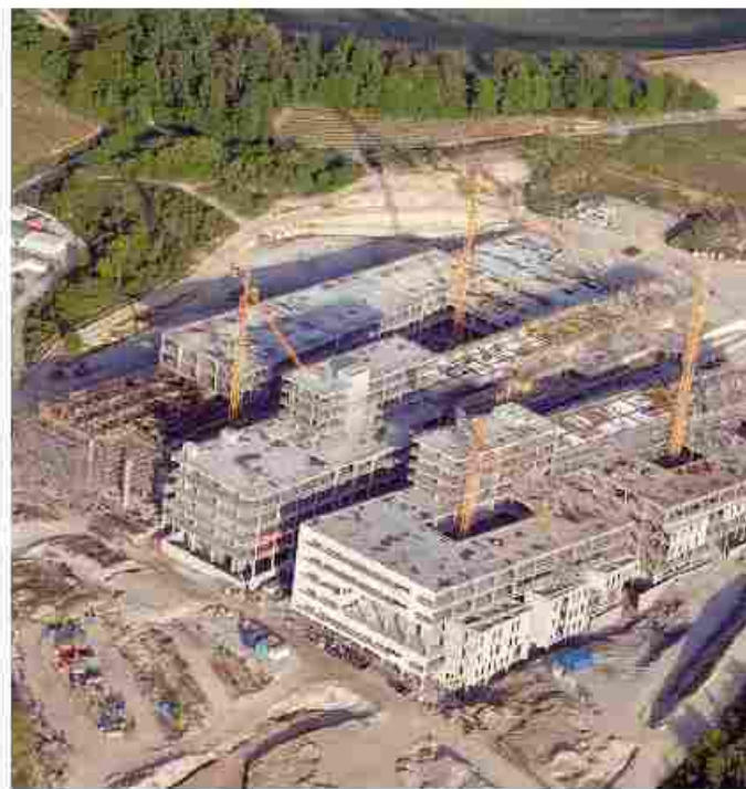
Il cantiere del nuovo ospedale a Verduno
