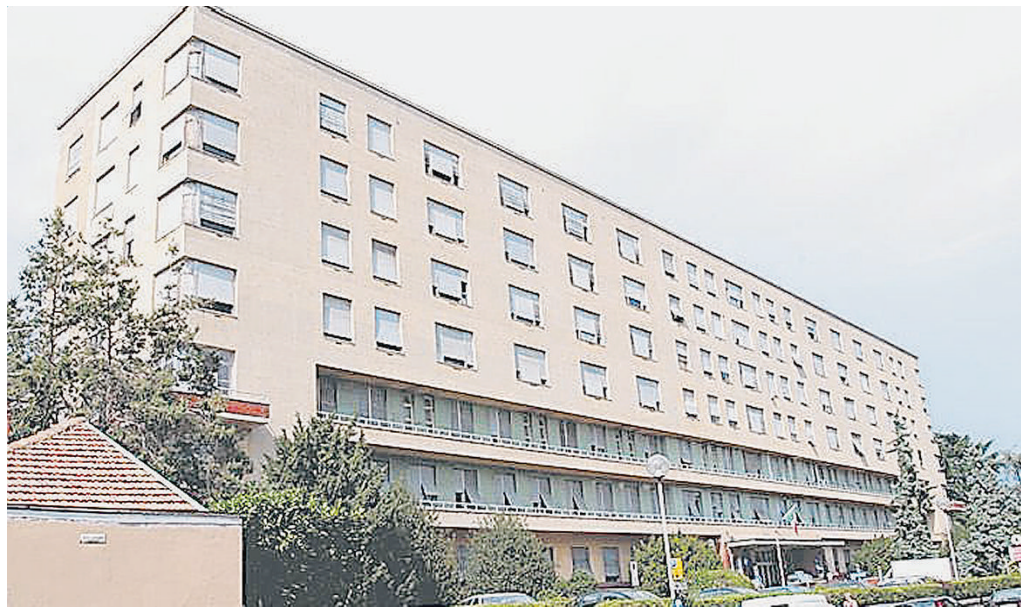
L'ospedale Degli Infermi è tra gli edifici destinati a passare in carico al fondo immobiliare regionale
